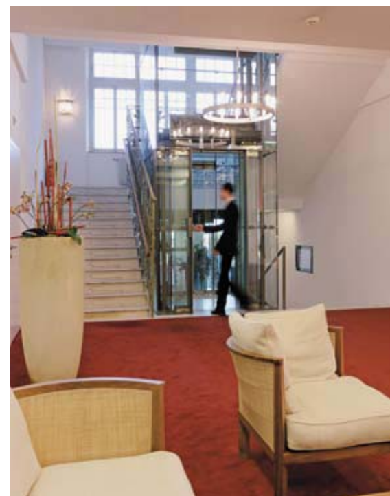
Um Tiefgarage und Rezeption mit dem Rest des Hotels zu verbinden, brauchte es einen neuen Lift. Für diesen Lift gab es jedoch nur einen einzigen möglichen Standort: das historische Treppenhaus.
