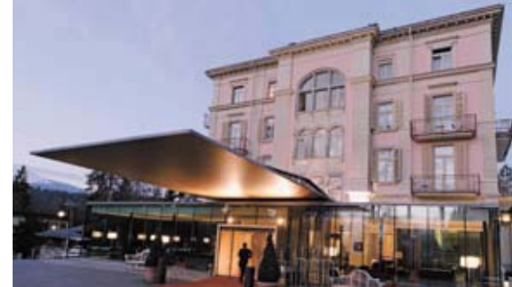
Der Lift von Emch: wesentlich für die Neugestaltung des Hotels
