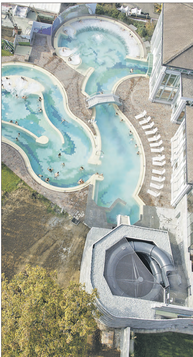
Das Aquarena-Angebot wurde ebenfalls ausgebaut: Die neue, 65 Meter lange und 8 Meter Gefälle aufweisende «Grottenrutsche» (im Bild rechts unten) ist ein echter Spassbringer.
