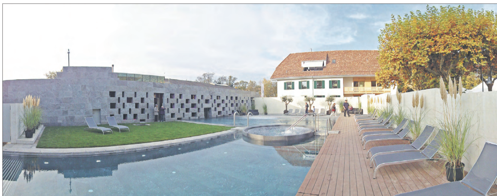
Am enorm gut besuchten Tag der offenen Tür konnte die Bevölkerung vergangenen Samstag auch den prächtigen Aussenbereich mit grossem Sonnendeck, abwechslungsreicher Poollandschaft und Liegewiese in Augenschein nehmen. Im Hintergrund ein Bau-Highlight: Die Gebäudehülle des 1786 errichteten Hofratsgebäudes wurde erhalten und verleiht dem neuen First-Class-Spa ein besonderes Cachet.
