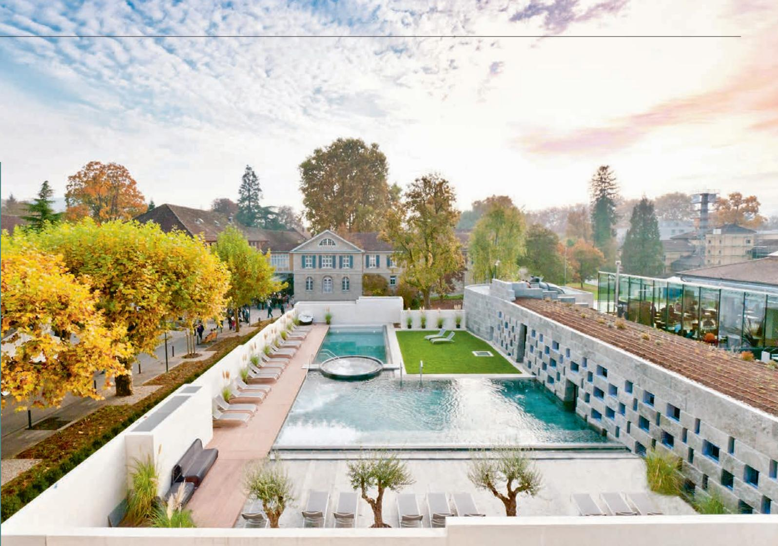
Zwischen dem Warmwasser- und dem Kaltwasserpool liegt ein kreisrunder Whirlpool mit einem Durchmesser von 4,25 Metern. Er setzt sich aus zwölf, je 1,8 Tonnen schweren, massiven Segmenten aus Tessiner Gneis zusammen. Dieser dunkle Naturstein wird in einem der grössten Steinbrüche der Schweiz im Onsernonetal gewonnen.
