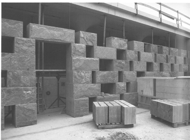
Die Massivmauer im Entstehen. Auf der untersten Lage sind die Blöcke 65 Zentimeter tief, auf der obersten sind es noch 20 Zentimeter.
