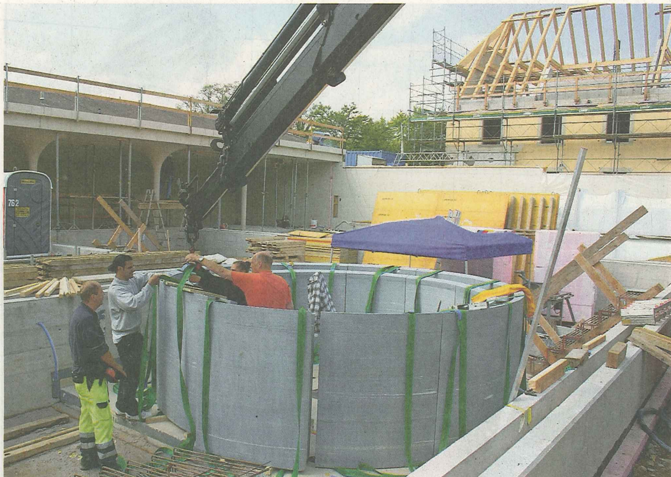
Die Segmente des Whirlpools werden gesetzt. Links der Ruhe- raum, rechts das Hofratsgebäude.
